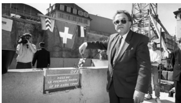
Il 29 aprile 1994, il cantiere del nuovo edificio dell'UST ha accolto personalità politiche per la posa della prima pietra, suggellata dal Presidente federale Otto Stich.
