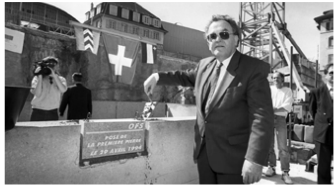
Le 29 avril 1994, le chantier du nouveau bâtiment de l'OFS accueille des personnalités du monde politique pour la pose de la première pierre, scellée par le président de la Confédération Otto Stich.
