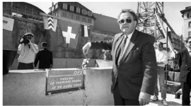
Am 29. April 1994 begrüsst die Baustelle des neuen BFS-Gebäudes Persönlichkeiten aus der Politik zur Grundsteinlegung, versiegelt durch Bundespräsident Otto Stich.
